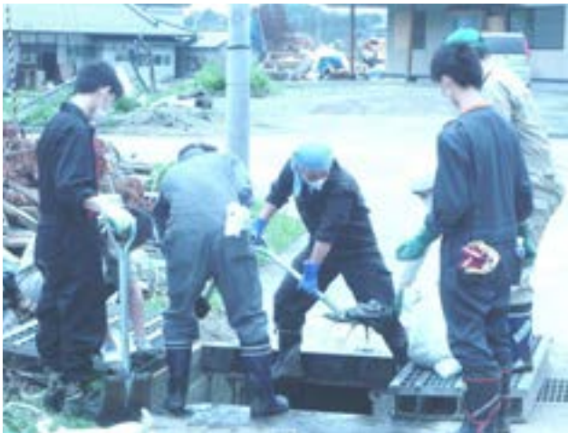
高校生も側溝の泥出し作業を行った
