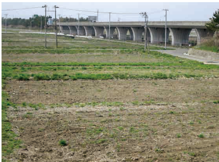
【定点観測】2012.4.29 一年後、塩害処理作業が進む。まだ田植えはできない（撮影／NPO法人20世紀アーカイブ仙台）
