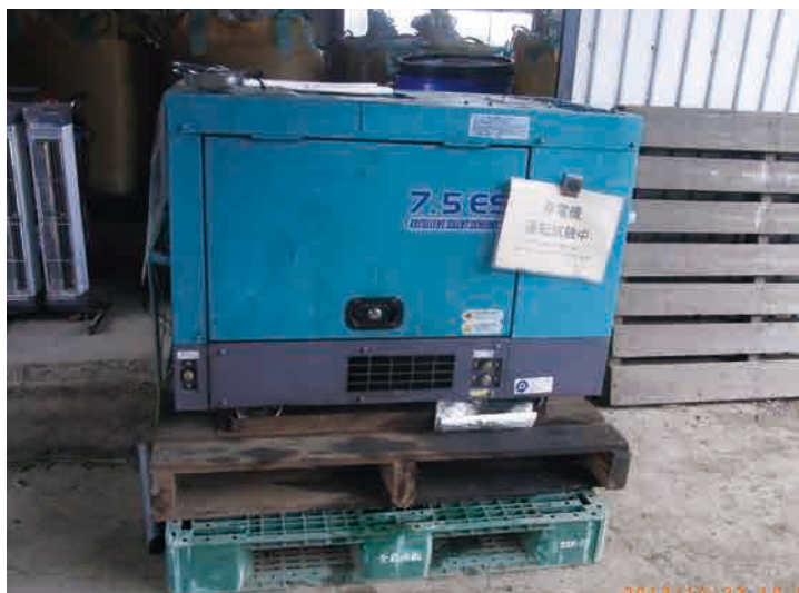
BDFで発電機を運転試験中
