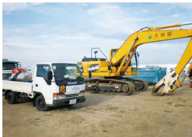
燃料を重機へ供給した（千田信良さん提供）
