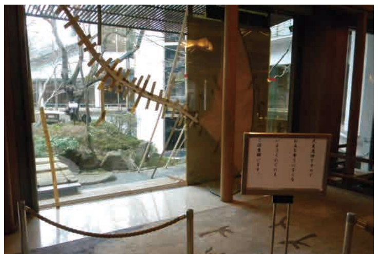
撮影：2011.3.21 破損したロビーのガラス
