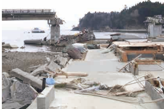
撮影：2011.4.7 津波で壊れた橋
