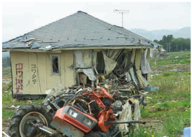
撮影：2011.5.13 倒壊家屋の壁にスプレーでメッセージ
