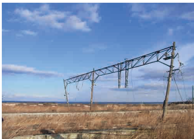
撮影：2014.2.19 福島県双葉郡富岡町 線路 (EPOスタッフ撮影)
