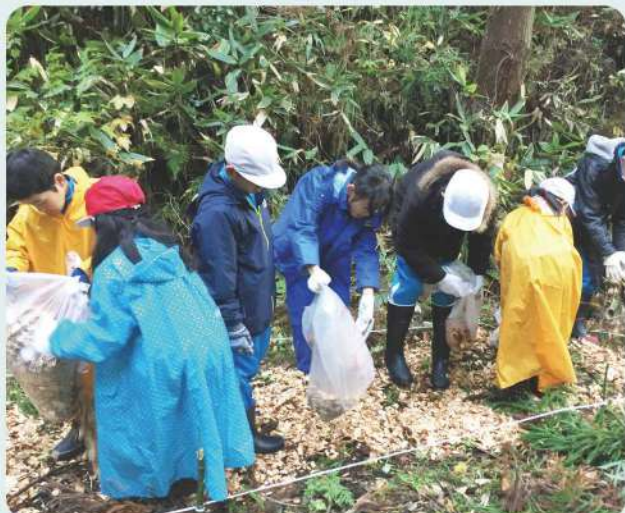
三瀬地区 避難道整備(木質チップ敷き)
