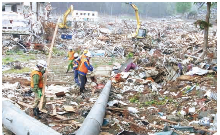
撮影：2011.5.28 瓦礫撤去をするボランティア
