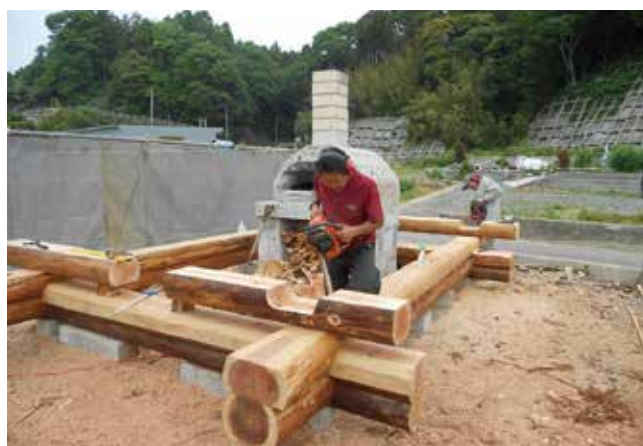
撮影：2012.6.15 石窯をログハウスで囲んでいく作業
